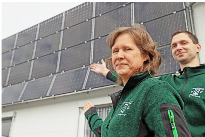
Ramona Eßbach, Geschäftsführerin von Entwicklung und Fertigung Eßbach, und Projektgenieur Matti Kaltoven zeigen die neu installierte Solaranlage an der Südseite des Firmengebäudes. Foto: Wieland Josch
