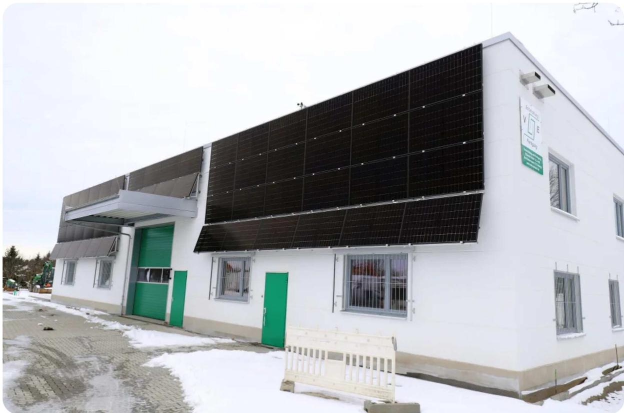
Die neue Lagerhalle von EFE am Rotvorwerk verfügt über eine Photovoltaikanlage für 30 KWp.
